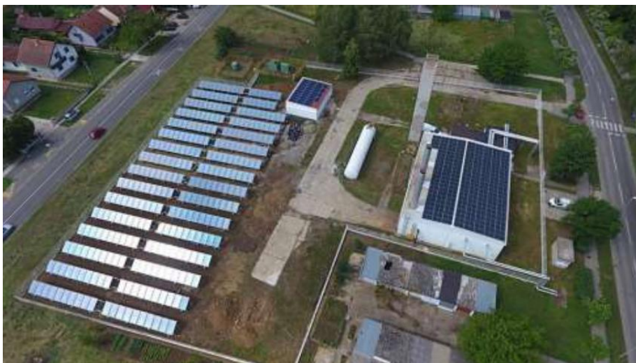
Sl. 6–33 Solarna toplana planiranog ukupnog toplinskog učina 900 kW
