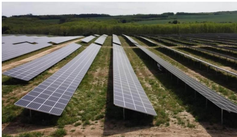
Sl. 6–52 Varijanta smještaja FN modula u konfiguraciji jug
