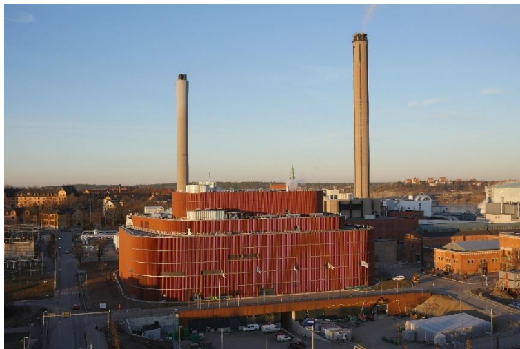
Sl. 6–58 Kogeneracijski postrojenje Värtaverket u Stockholmu
