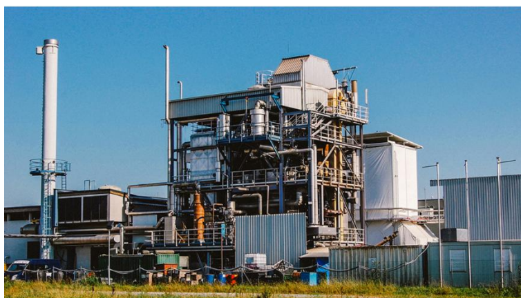
Sl. 6–59 Kogeneracijsko postrojenje Güssing
