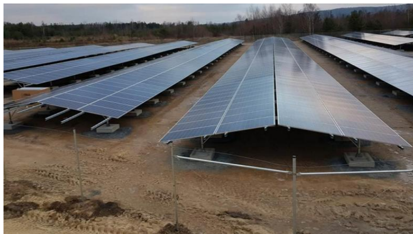
Sl. 6–51 Varijanta smještaja FN modula u konfiguraciji istok-zapad
