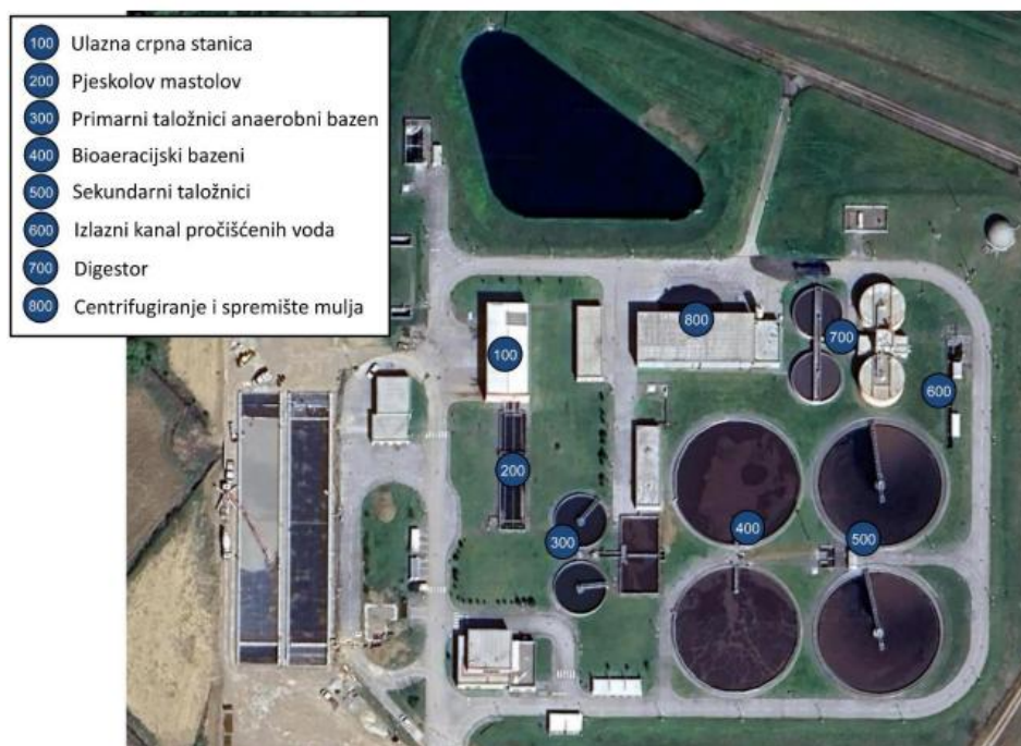
Sl. 6–44 Uređaj za pročišćavanje otpadnih voda Karlovac (Gornje Mekuše)
